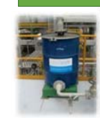
โครงการติดตั้ง Carbon Canister ที่ Load
